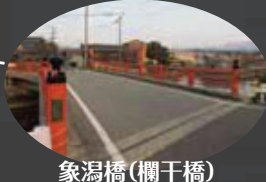
象潟橋(欄干橋)
